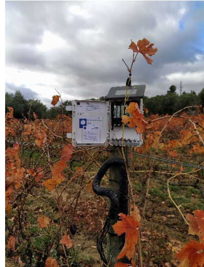
Figura 12: Sistema de registre de dades automàtic instal·lat en una finca de vinya d'Horta de Sant Joan, que recull les dades dels sensors d'humitat del sòl enterrats a la parcel·la.
