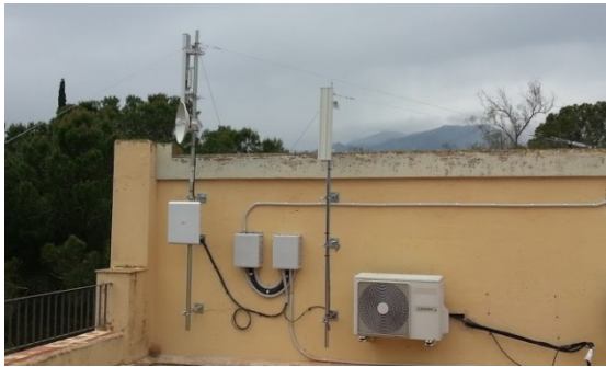
Fig. 11. Detalle de las antenas Guifi.net instaladas en el OE.
