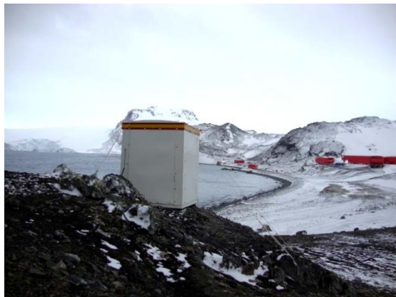
Fig. 4. Detalle de una de las infraestructuras que alberga instrumentación del OE en la BAE.
