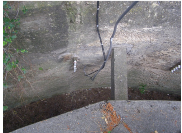
Cables cortados a la entrada del edificio
