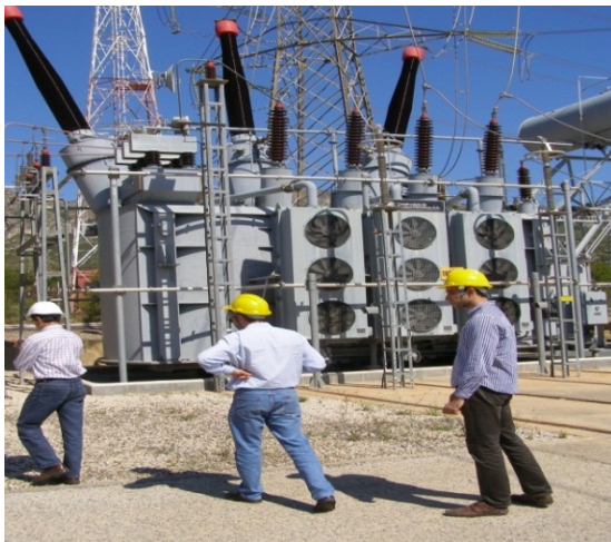
Visita de trabajo a las instalaciones de la subestación transformadora de ENDESA en Vandellós.
